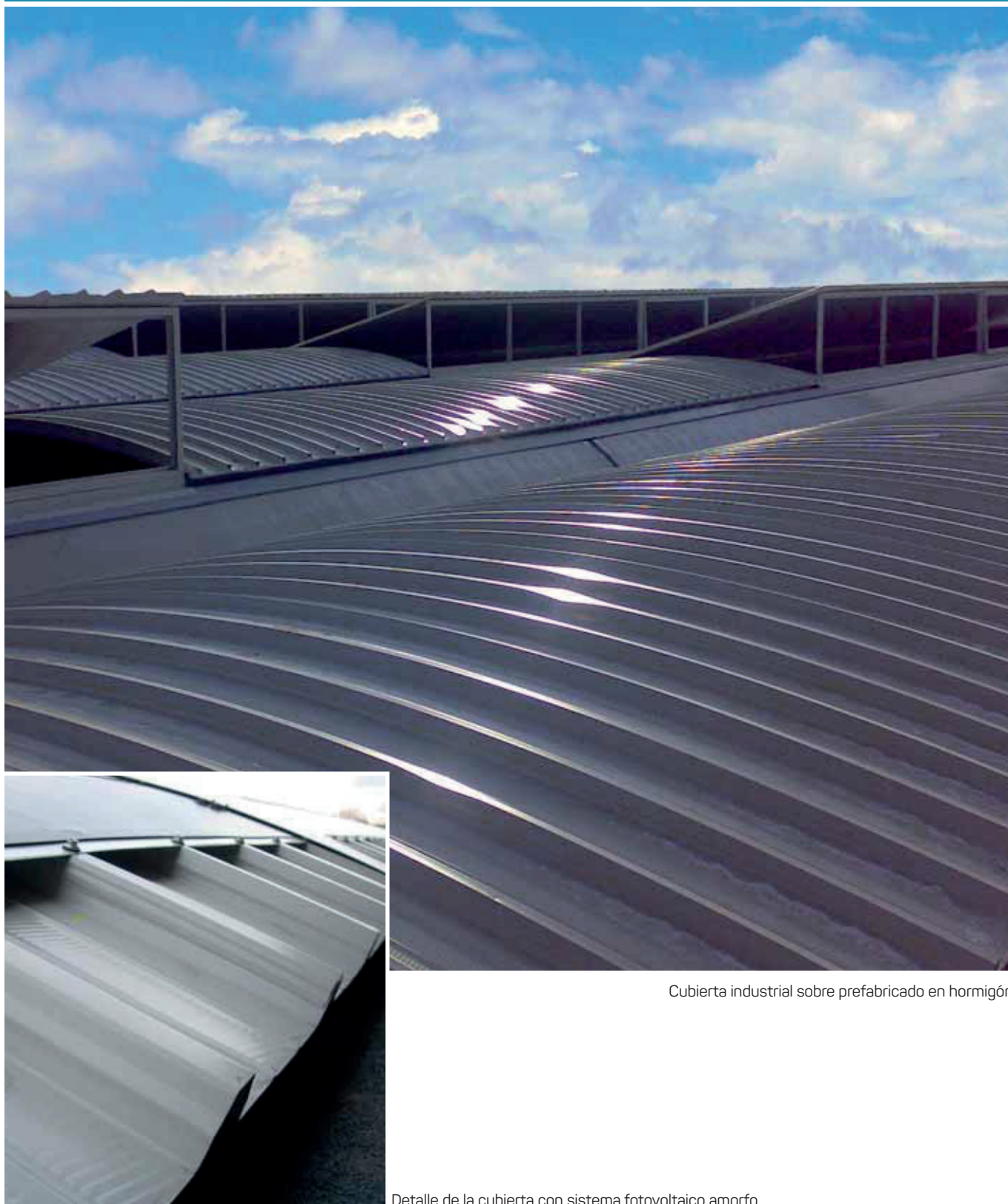
Detalle de la cubierta con sistema fotovoltaico amorfo.
